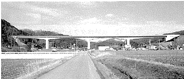
写真-7 八田川橋全景
