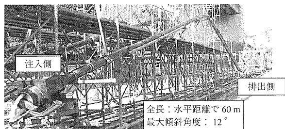
写真-11 試験体ダクトの全景
