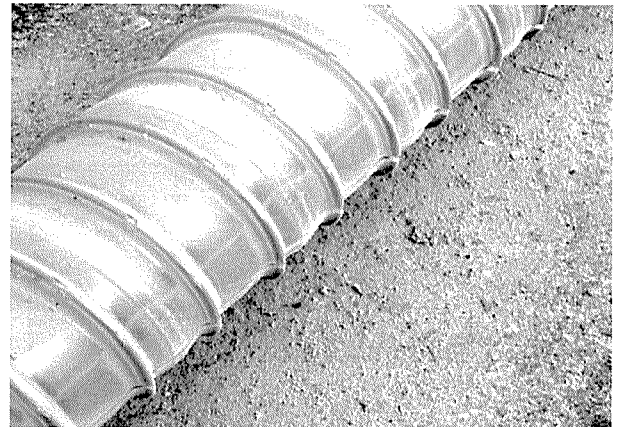
写真-4 リブ部における充填状況
