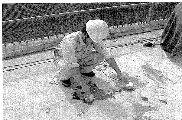
写真 - 9 広帯域超音波による探査状況
