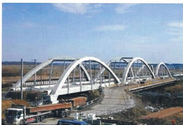
写真 - 1 天間川橋梁全景
