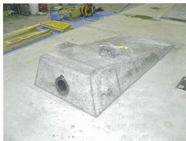
写真-5 あと施工型定着突起
