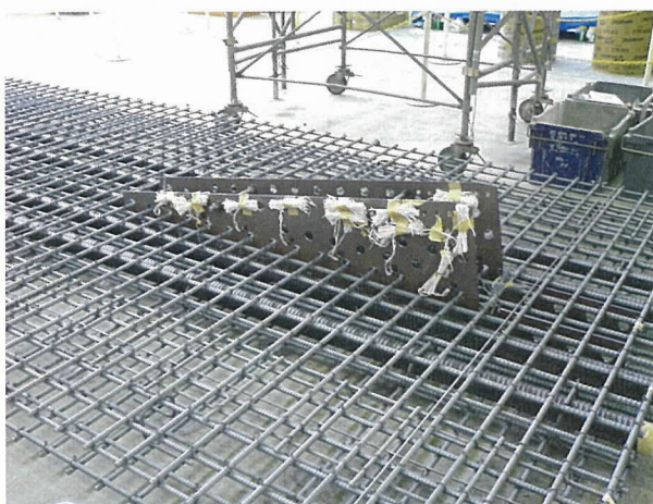
写真-2 孔あき鋼板の設置
