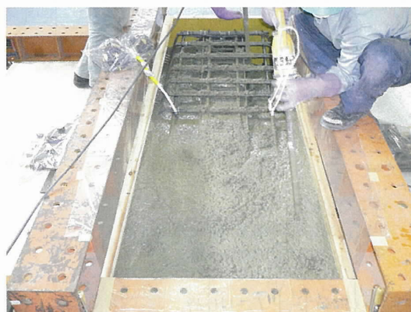
写真-4 型枠セット・コンクリート打設
