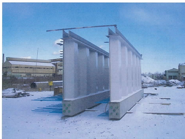
写真-1 ブロック部材で完成した波形鋼板手延べ桁
