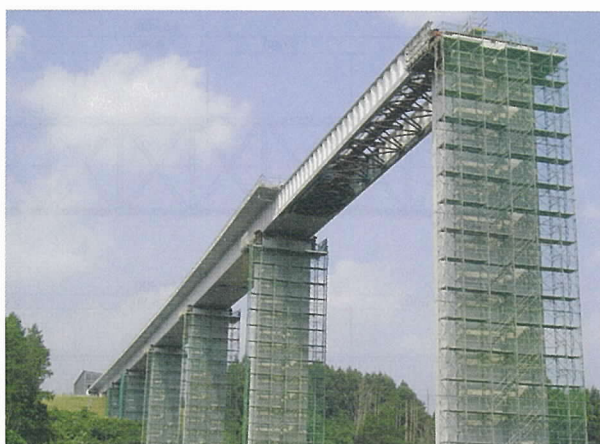
写真-2 波形鋼板手延べ桁
