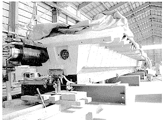
写真 - 13 階段部材緊張状況
