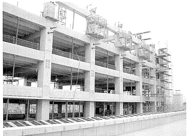
写真 - 16 緊張作業ステージ取付け状況
