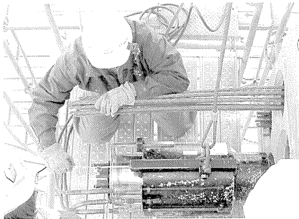
写真 - 15 緊張作業状況 (260tジャッキ)
