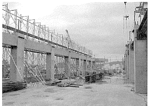
写真 - 2 プレキャスト柱および PC 圧着梁の架設状況
