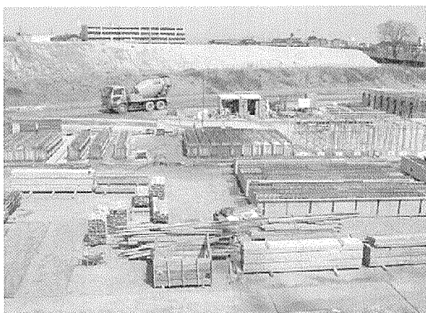
写真 - 4 サイトプレキャスト製作ヤード
