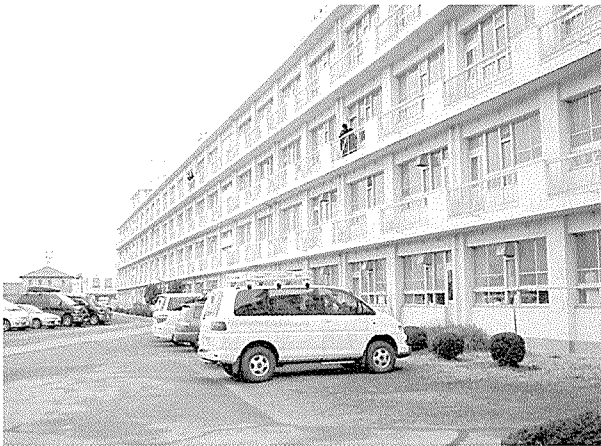
写真 - 3 補強前外観
