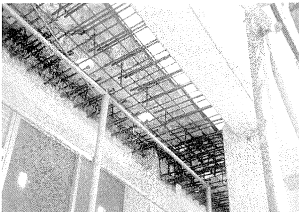
写真 - 6 新設スラブの配筋状況
