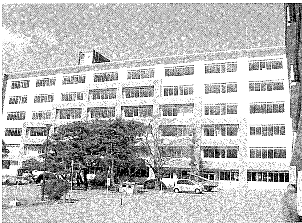
写真 - 9 補強後外観
