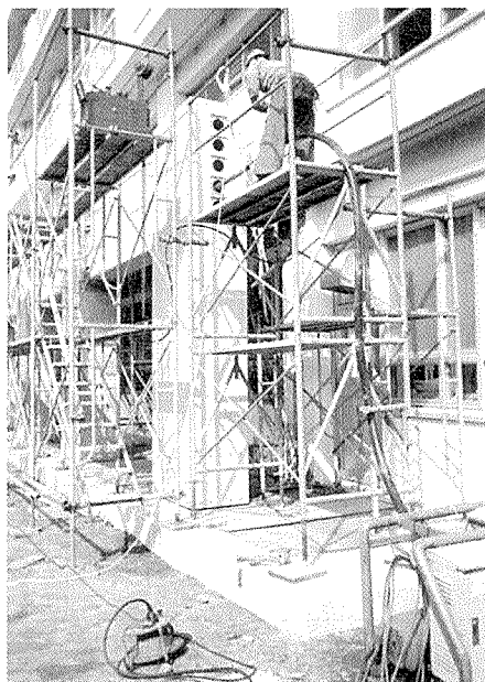
写真 - 7 PC 鋼材の通線状況
