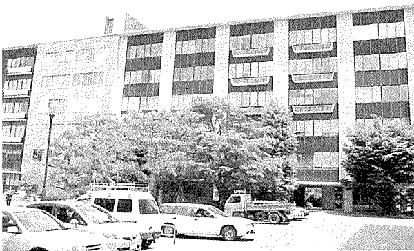
写真 - 8 補強前外観
