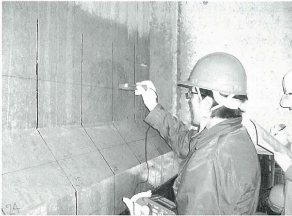
写真 - 1 自然電位の測定状況
