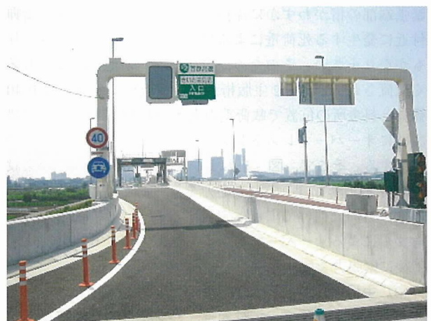
写真 - 6 開通前状況（平成 18 年 8 月）
