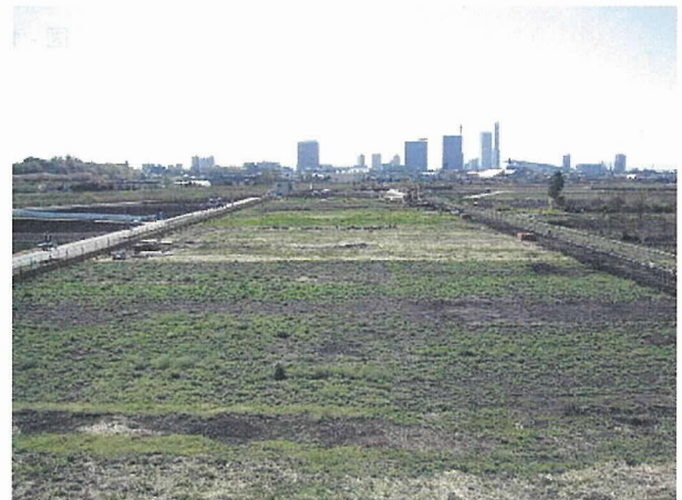
写真 - 5 架橋地点施工前状況
