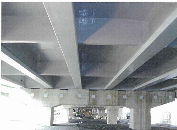
写真-1 小余綾高架橋 (P45 - P47)
