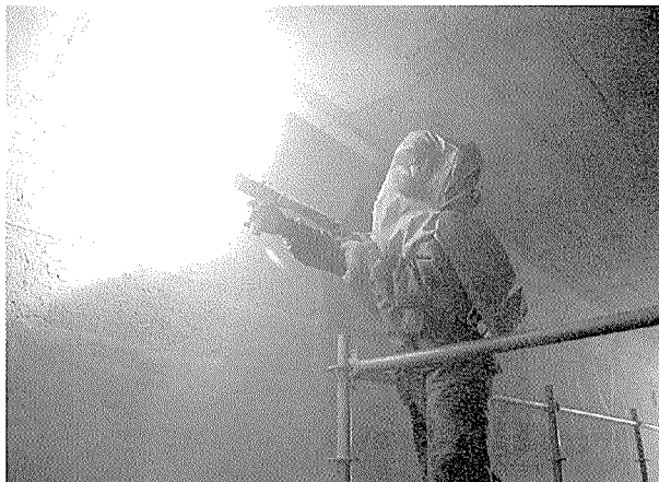
写真-7 流電被覆材の溶射状況
