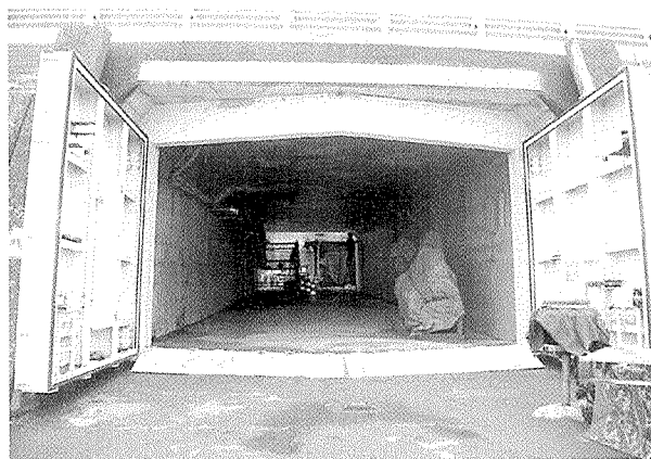
写真-6 ボックスカルバートの施工前状況
