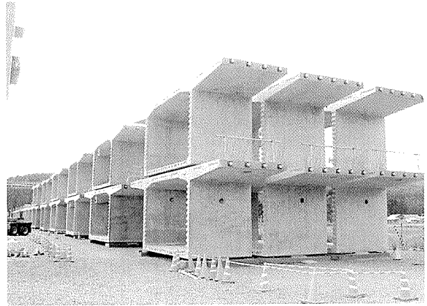
写真-5 セグメント仮置き状況
