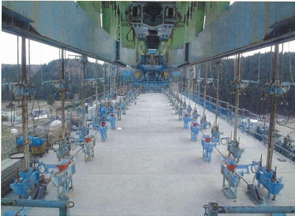
写真 - 9 セグメント接合終了状況
