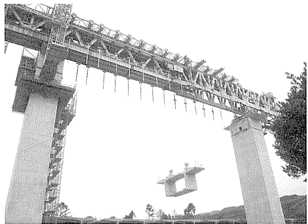
写真 - 8 セグメント架設状況
