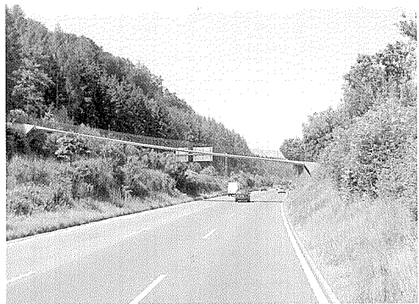
写真 - 12 ビルヘアバイトの歩道橋全景
