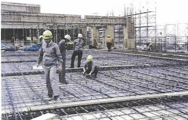
写真-2 施工中の近畿郵政省資材部倉庫の床スラブ
