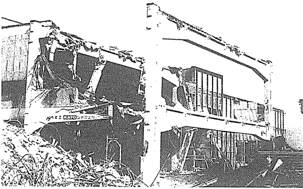
写真-1 解体中の(株)丸見屋向島工場 PC フレーム
