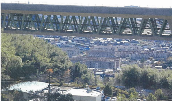
写真 - 6 猿田川橋・巴川橋 (静岡県)
