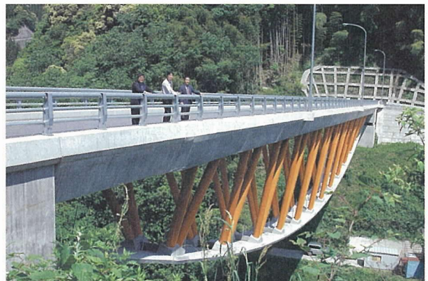
写真 - 9 青雲橋 近景 (2006.5.12 撮影)
