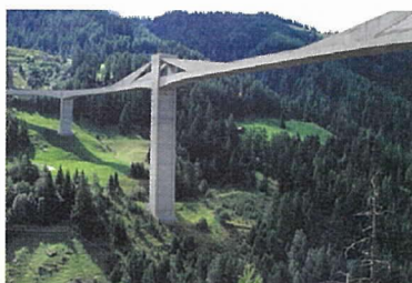
写真-2 ガンター橋
