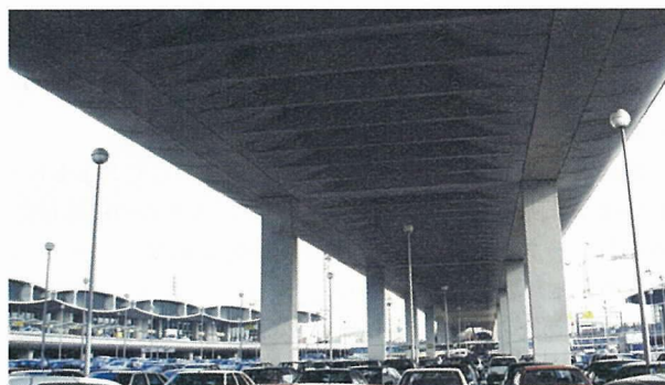
写真-9 建物に調和し、桁下も美しい シャルル・ド・ゴール空港内高架橋
