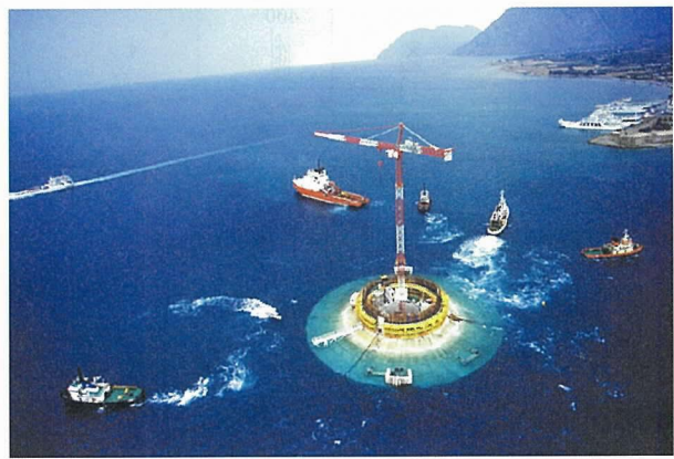
図-3 ドライドックからファンデーシンの曳航状況
