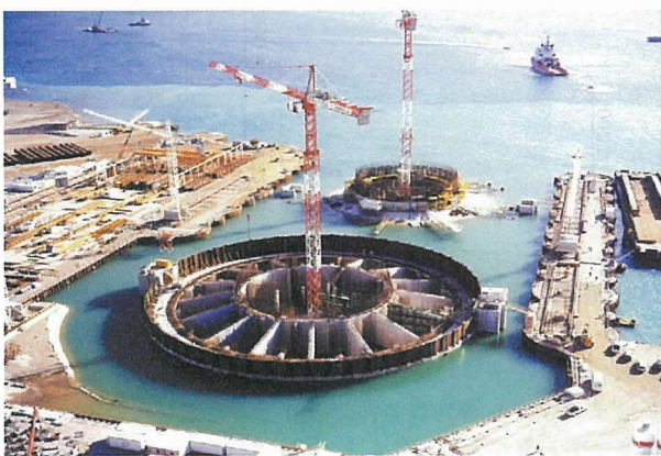
図-3 ドライドックからファンデーシンの曳航状況
