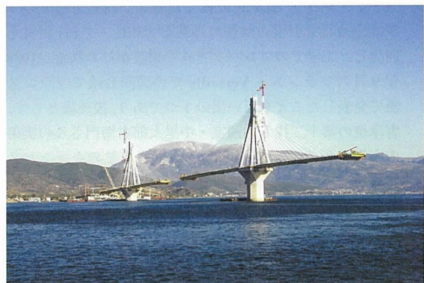
図-5 上部工 片持ち梁架設状況 (2003/10/13)
