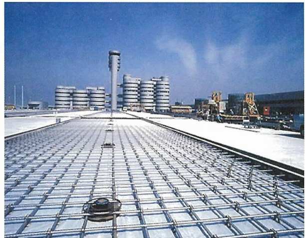
写真 - 1 羽田空港の PC エプロン舗装
