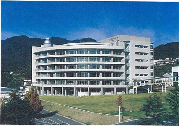
写真-1 安田学園外観 近景(東)
