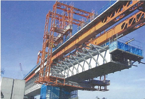
写真 - 5 コア断面先行施工技術の応用例
