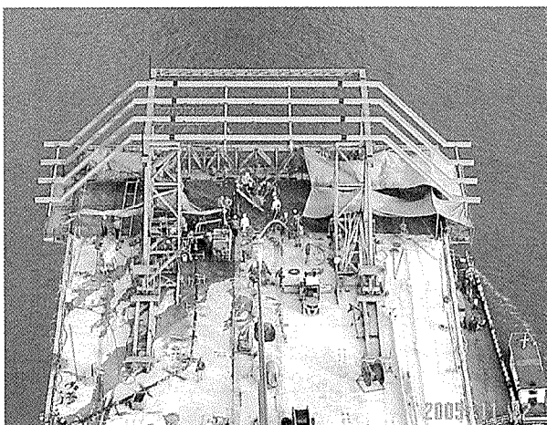
写真 - 3 主桁コンクリート打込み
