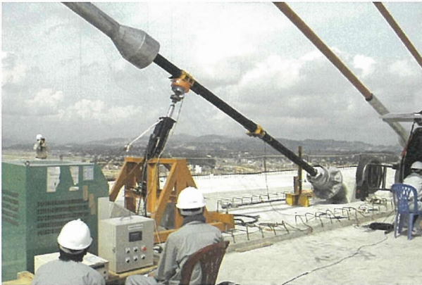
写真 - 12 斜材振動実験
