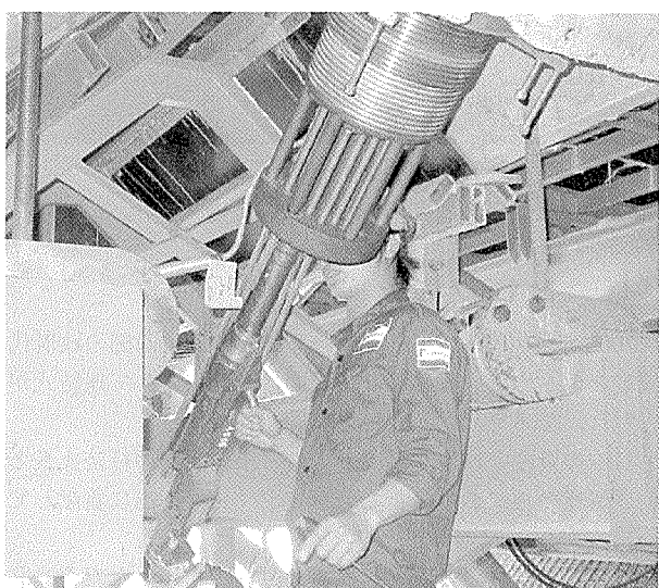
写真 - 10 シングルストランドジャッキによる緊張作業
