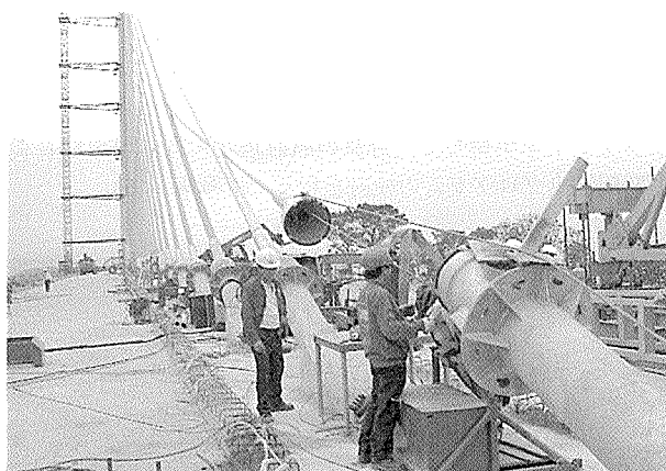
写真 - 9 保護管、第 1 ストランドの架設
