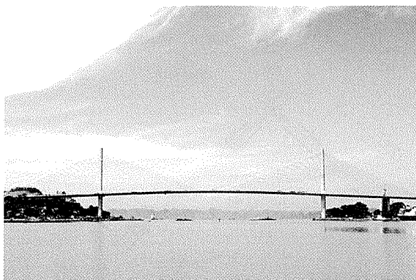
写真-1 バイチャイ橋（主橋全景）
