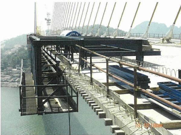
写真 - 13 地覆用移動式型枠
