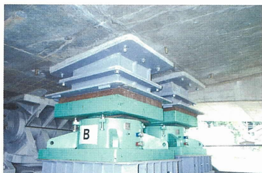
写真-3 P2支点ジャッキアップ状況
