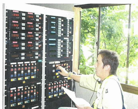
写真-4 反力・変位集中制御状況
