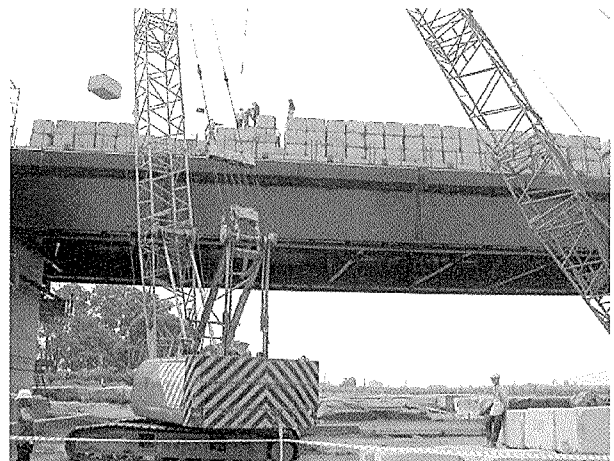
写真 - 5 MSS の載荷試験状況
