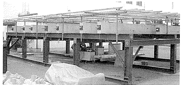
写真 - 3 PC 梁試験体暴露状況
