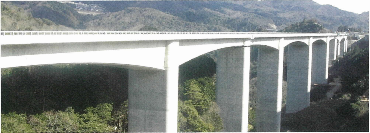
写真 - 1 橋梁全景
