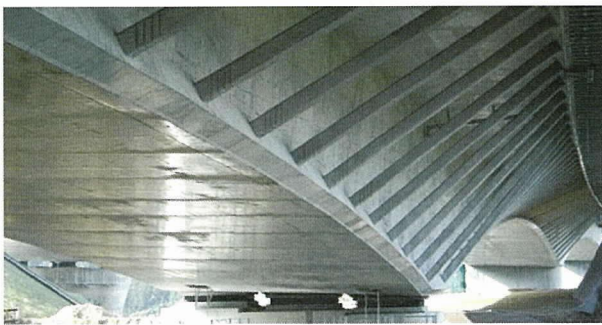
写真 - 2 ストラット配置部
