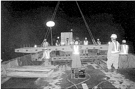
写真-2 大川橋 床版取換え状況
