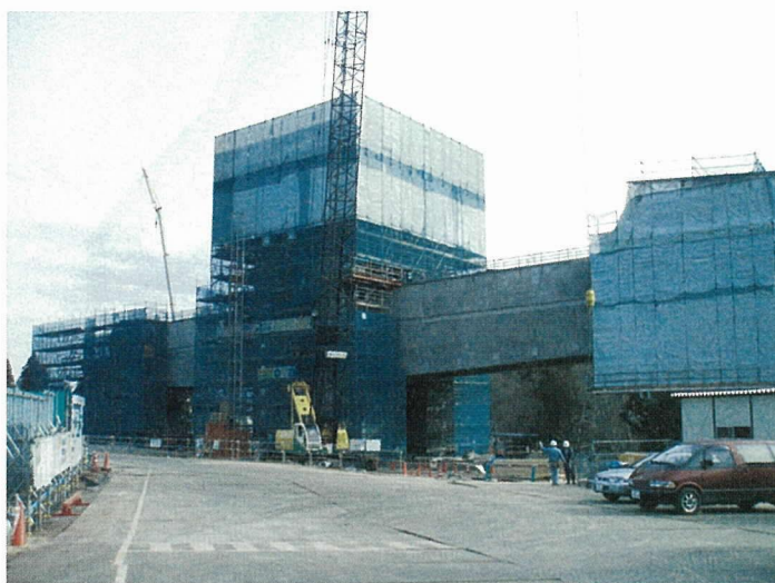
図 - 15 現況写真 (P2 橋脚)
