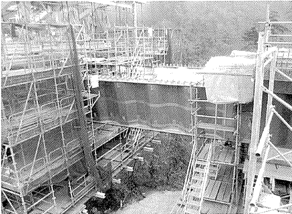
写真 - 3 波形鋼板先行架設施工状況（六橋側径間）
