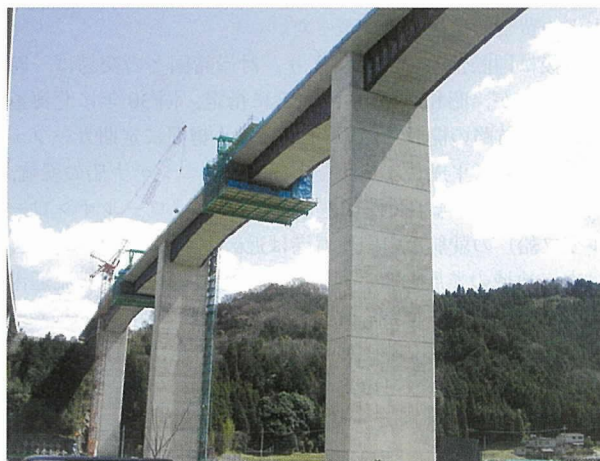
写真-7 橋体完成前の杉谷川橋（下り線）
