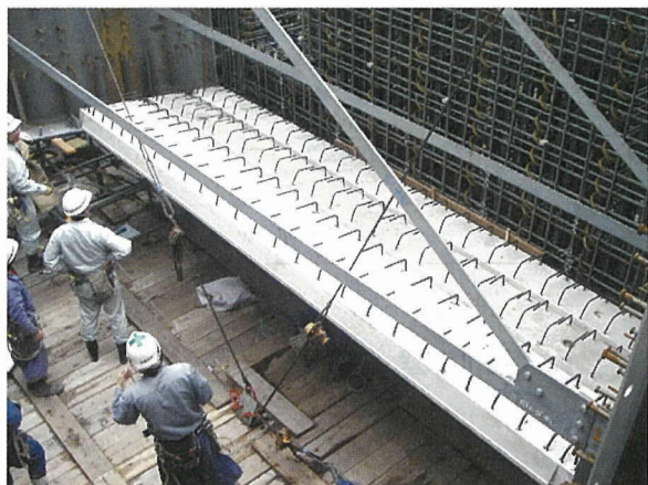
写真-4 柱頭部施工状況
