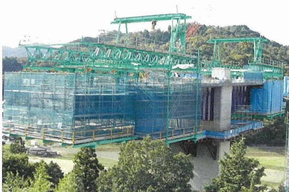
写真-5 張出し施工中の架設機
