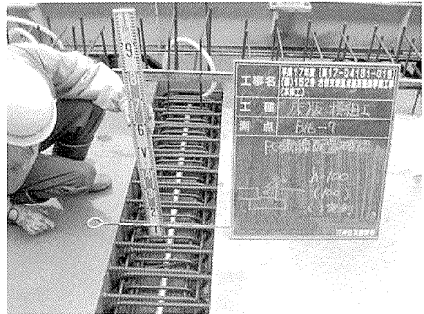
写真-6 床版間詰め部（リブ上）
