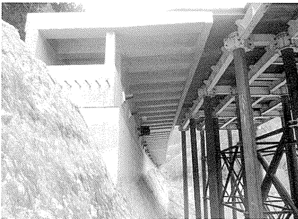
写真 - 9 B13 ブロック端部と栈橋
