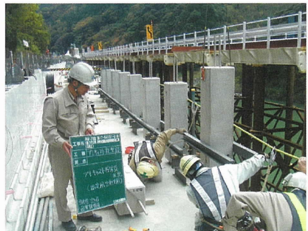
写真 - 3 プレキャスト柱の架設
