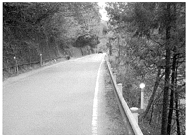
写真 - 1 現道状況
