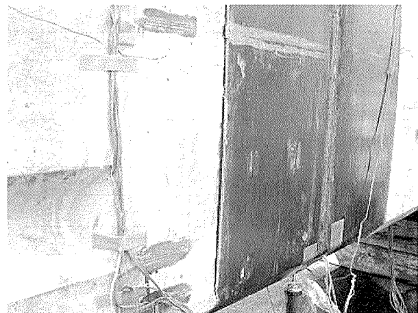
写真 - 3 最大荷重時の継手部の状況 (側面)
