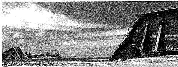
図-6 (a) 崩壊時の全景
