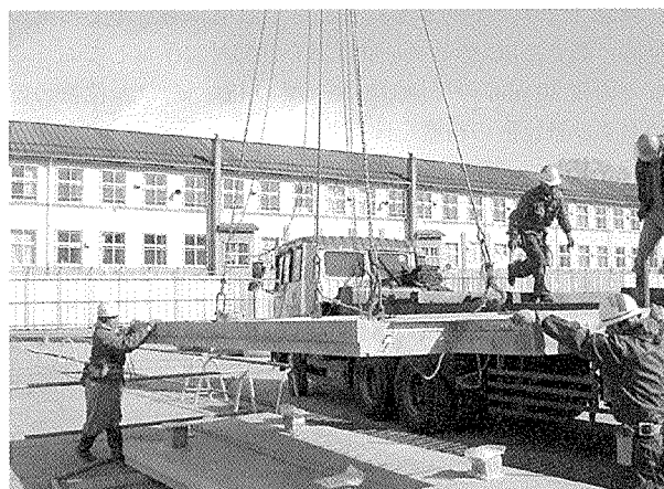
写真 - 15 PCa バルコニー版搬入状況
