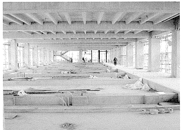
写真-7 スラブ段差 (トップコン打設完了後)
