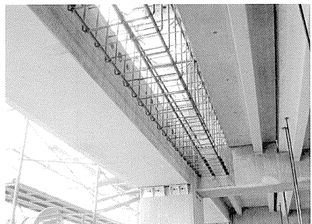
写真-8 ブリッジ連結部
