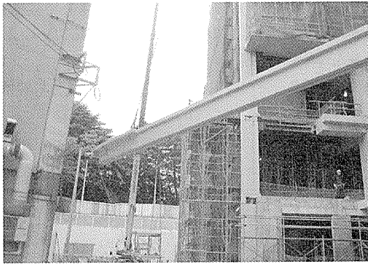
写真 - 21 2階 東 底版 架設状況
