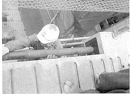
写真 - 23 7階 ブリッジ版 タイロッド挿入状況
