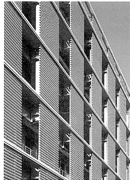
写真-2 外装 セラミックルーバー
