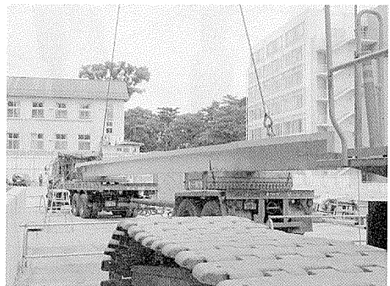
写真 - 19 2 階 東 庇版 搬入状況
