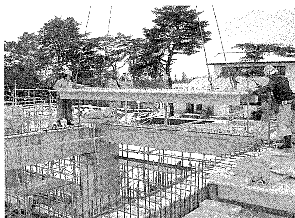
写真 - 16 PCa 合成床版架設状況
