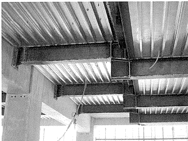
写真-5 長辺方向スラブ段差 (鉄骨+デッキプレート)
