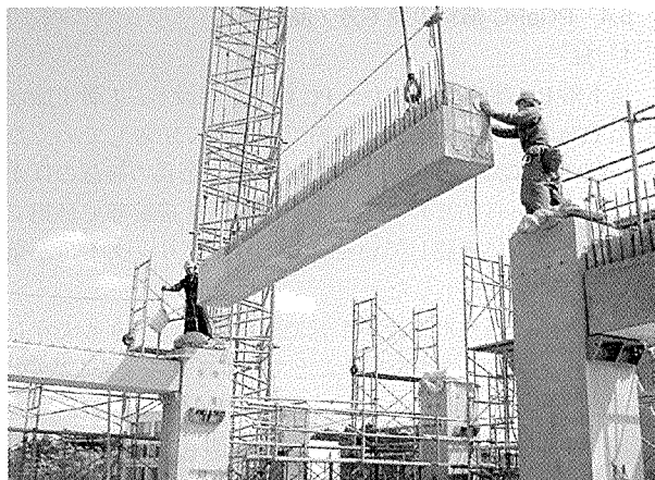
写真 - 14 PCa 梁架設状況 (スパン梁)
