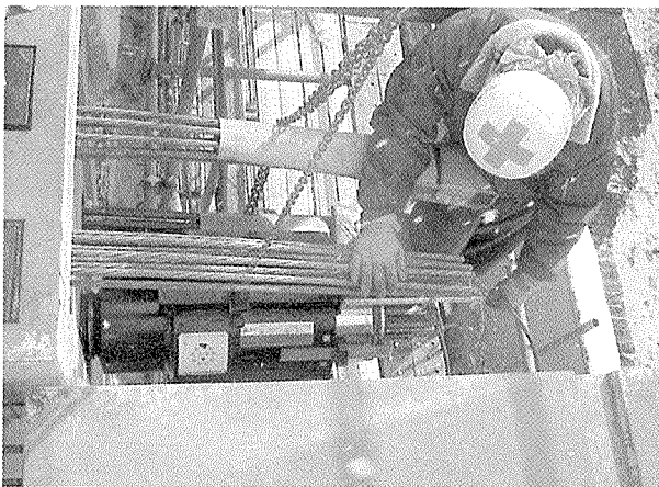
写真 - 17 2 階 スパン梁 2 次緊張状況
