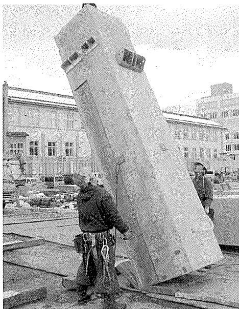
写真 - 13 PCa 柱建起し状況
