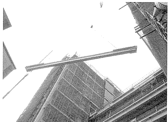
写真 - 20 2 階 東 庇版 架設状況
