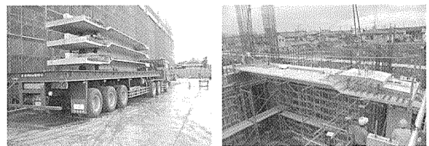
写真 - 6 PC 床板の架設
