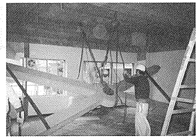
③ブレース建て起こし
