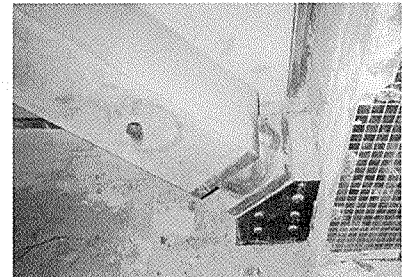
⑥グラウト充てん後のブレース脚部
