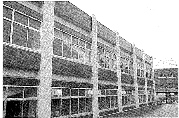
写真-2 建物外観
