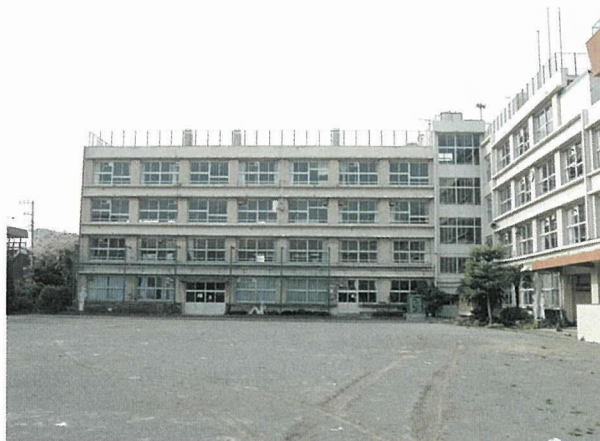
写真 - 1 補強前の建物外観
