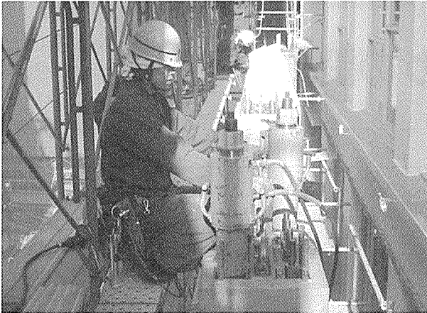
写真 - 10 PCa 柱 PC 鋼棒緊張
