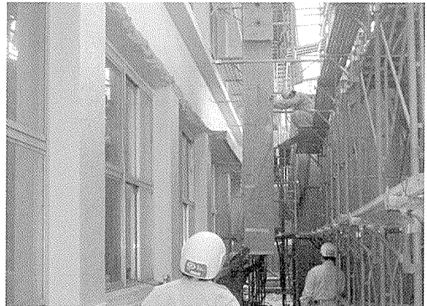
写真 - 7 PCa 柱建て込み
