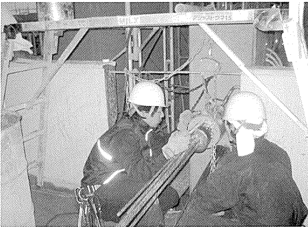
写真 - 11 PCa 梁 PC 鋼棒緊張
