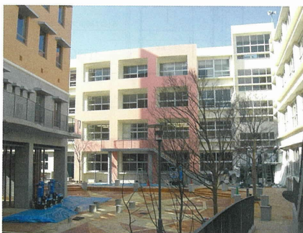
写真 - 3 補強後の建物外観
