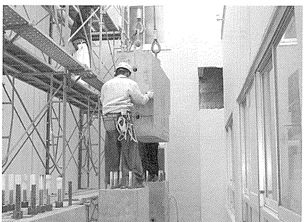
写真 - 9 PCa 梁建て込み
