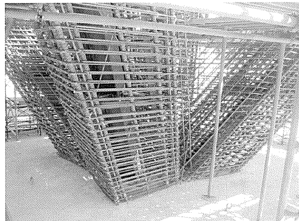
写真 - 2 斜め柱配筋施工
