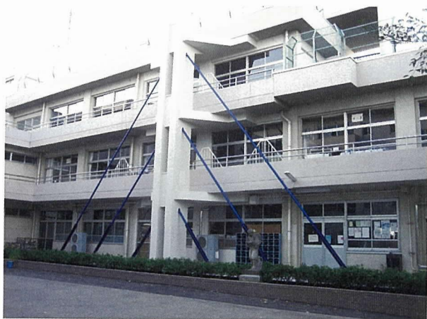
写真 - 1 補強後の概観 (1)
