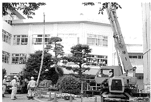
写真 - 6 斜め PC 鋼材の配線
