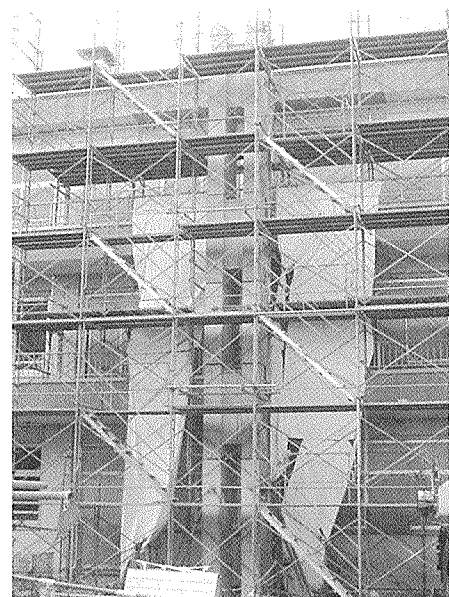
写真 - 5 PCa 柱の建て方状況 (2)
