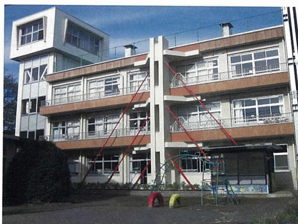
写真 - 2 補強後の概観 (2)
