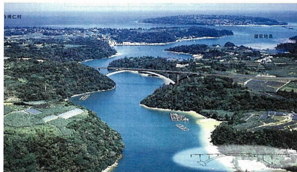
写真 - 1 架橋位置
