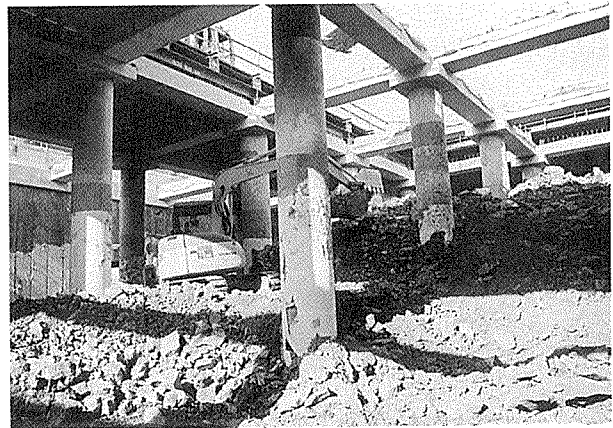
写真 - 8 調整池内掘削状況
