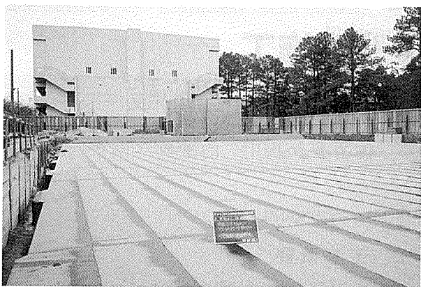
写真 - 11 床版防水完成
