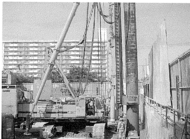
写真 - 2 PC 壁体設置孔掘削状況
