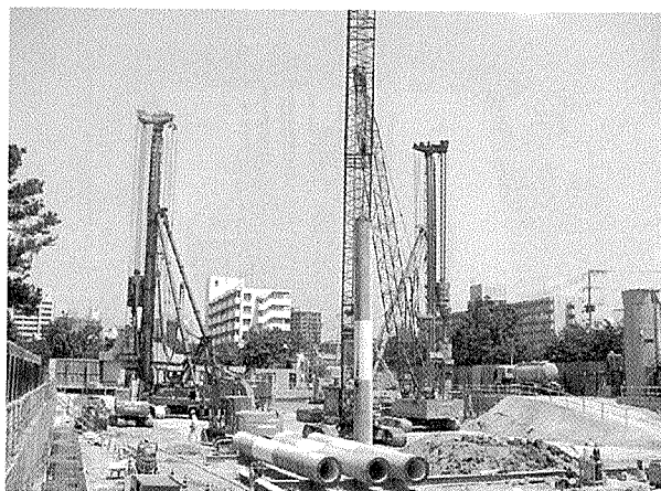
写真 - 4 PHC 杭の建込み状況
