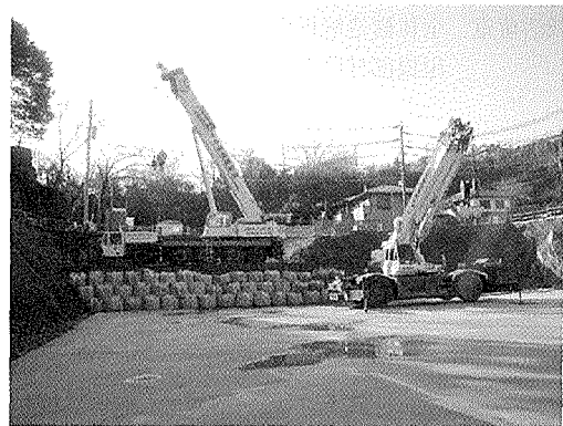
写真 - 2 架設用クレーン
