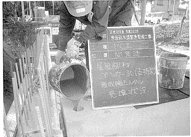
写真-6 アンカー孔モルタル充てん
