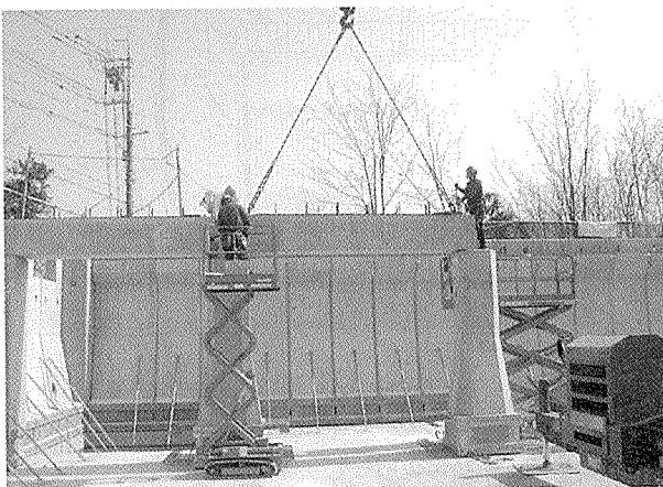
写真-5 支持梁架設
