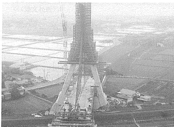
写真-2 矢部川橋 P2主塔頂部よりP1主塔を望む
