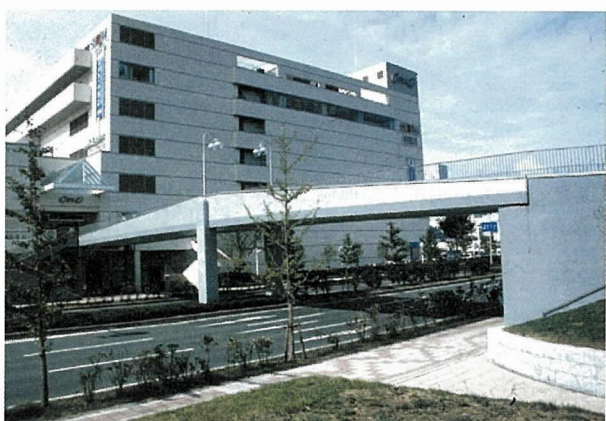
写真 - 7 中路 PC 構造の歩道橋（筑波研究学園都市）
