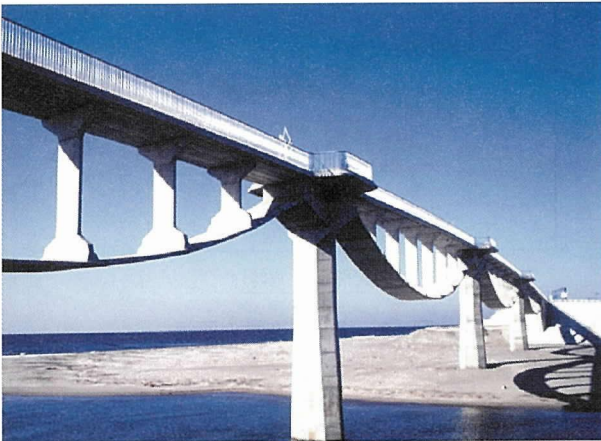
写真 - 3 潮騒橋 (静岡県)
