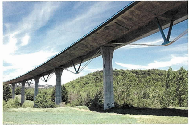
写真 - 5 Osormort 高架橋 (スペイン)
