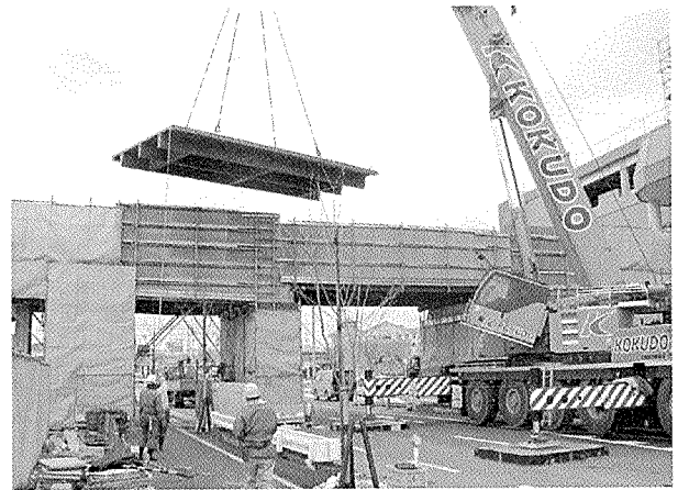
写真 - 4 セグメント架設状況
