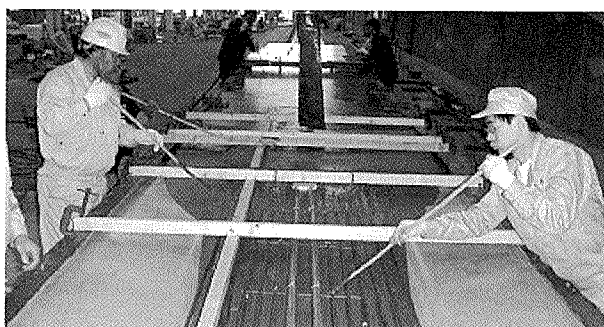
写真 - 4 実大模型試験体による打設施工状況
