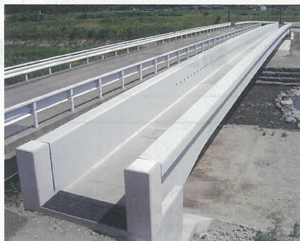
写真-16 架設完了(3)
