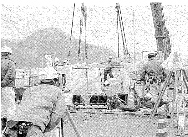
写真-10 セグメント架設完了
