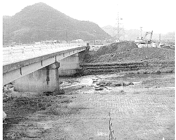
写真 - 1 着工前状況
