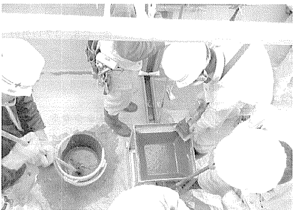
写真 - 12 ジョイント部打込み (ホッパー使用状況)
