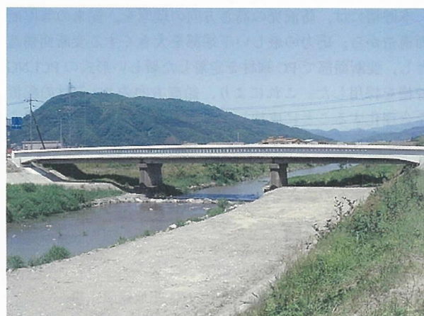
写真-17 架設完了(4)
