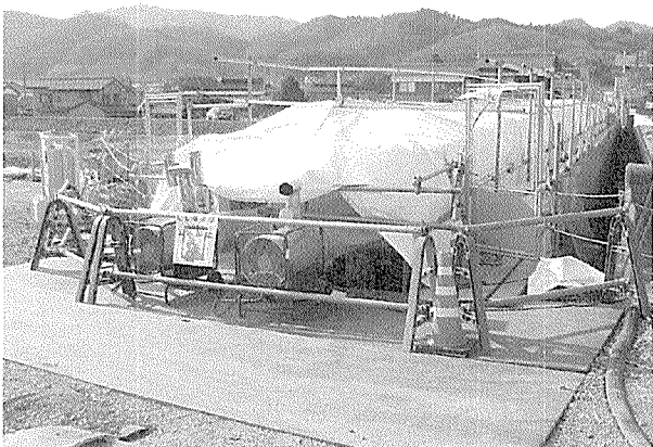
写真 - 13 給熱養生状況
