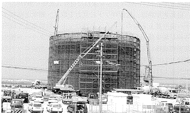
写真-7 防液堤コンクリート打設全景
