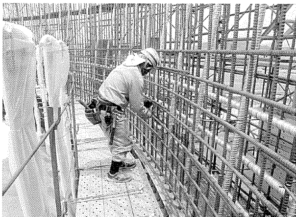
写真-6 鉄筋・PC シース組立て状況
