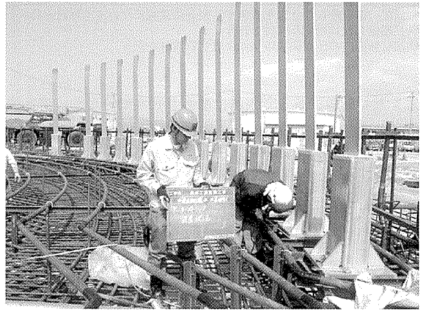
写真 - 4 アンカストラップセット状況
