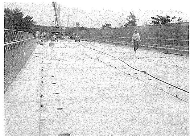
写真 - 15 敷設完了状況
