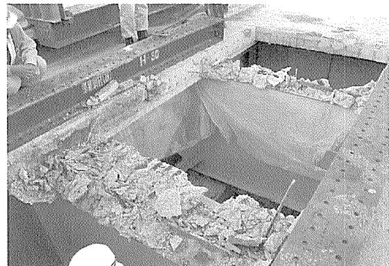
写真 - 6 既設撤去後の状況
