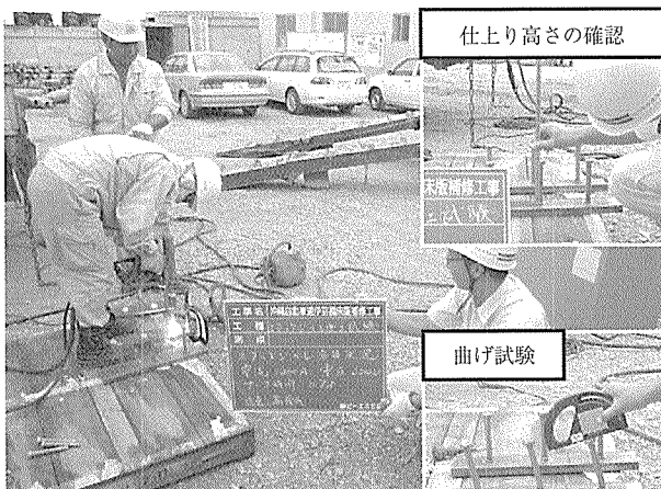
写真 - 12 スタッドジベル施工試験
