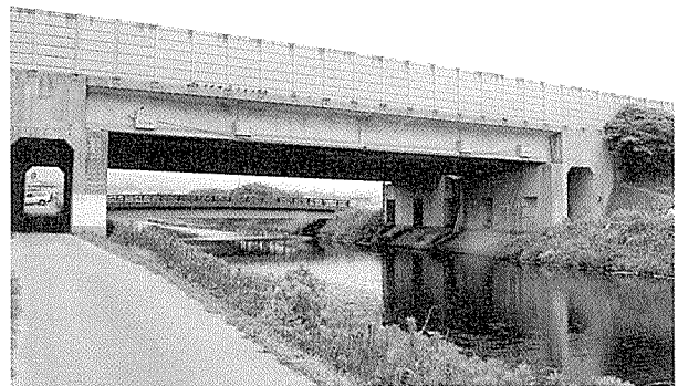
写真-2 外ケーブル補強の外観
